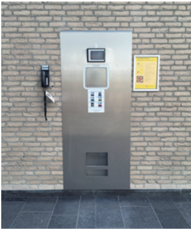
Abbildung 4: Wäscheversorgung durch dezentrale elektrische Schranksysteme im University Medical Center Groningen (Foto: von Eiff 2016)
